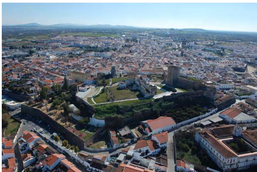
Imagen aérea recinto fortificado de Serpa.
